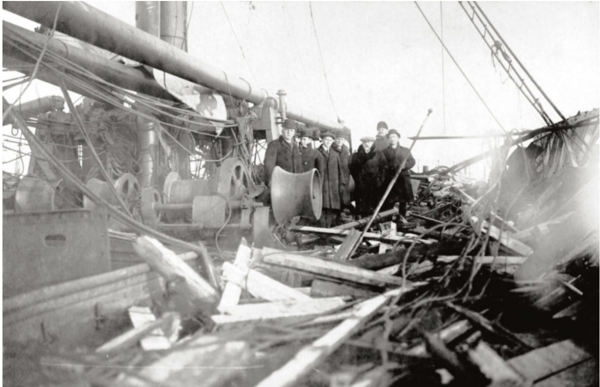
À bord du Curaca . Ce vapeur britannique de 122 mètres, qui chargeait des chevaux au moment de l'explosion, a été projeté sur la rive opposée des Narrows. Des quarante-six hommes d'équipage, un seul a survécu. © coll. Jean-Baptiste Glotin
